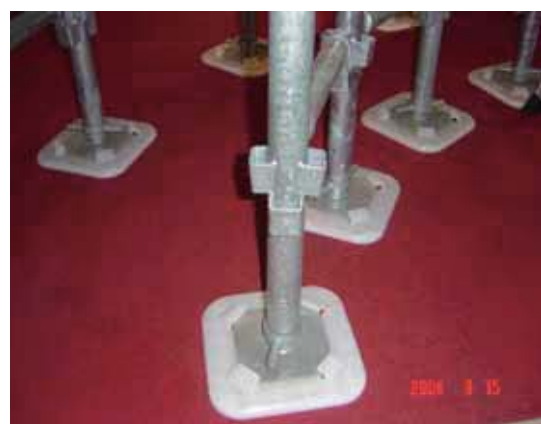
照片 5. 施工架腳部設置基座增加穩定性 (營造標準第 59 條及國家標準)
