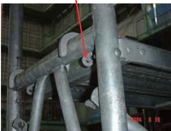
照片 4. 工作台設防脫落鉤增加連結性避免翻覆 (營造標準第 59 條及國家標準)
