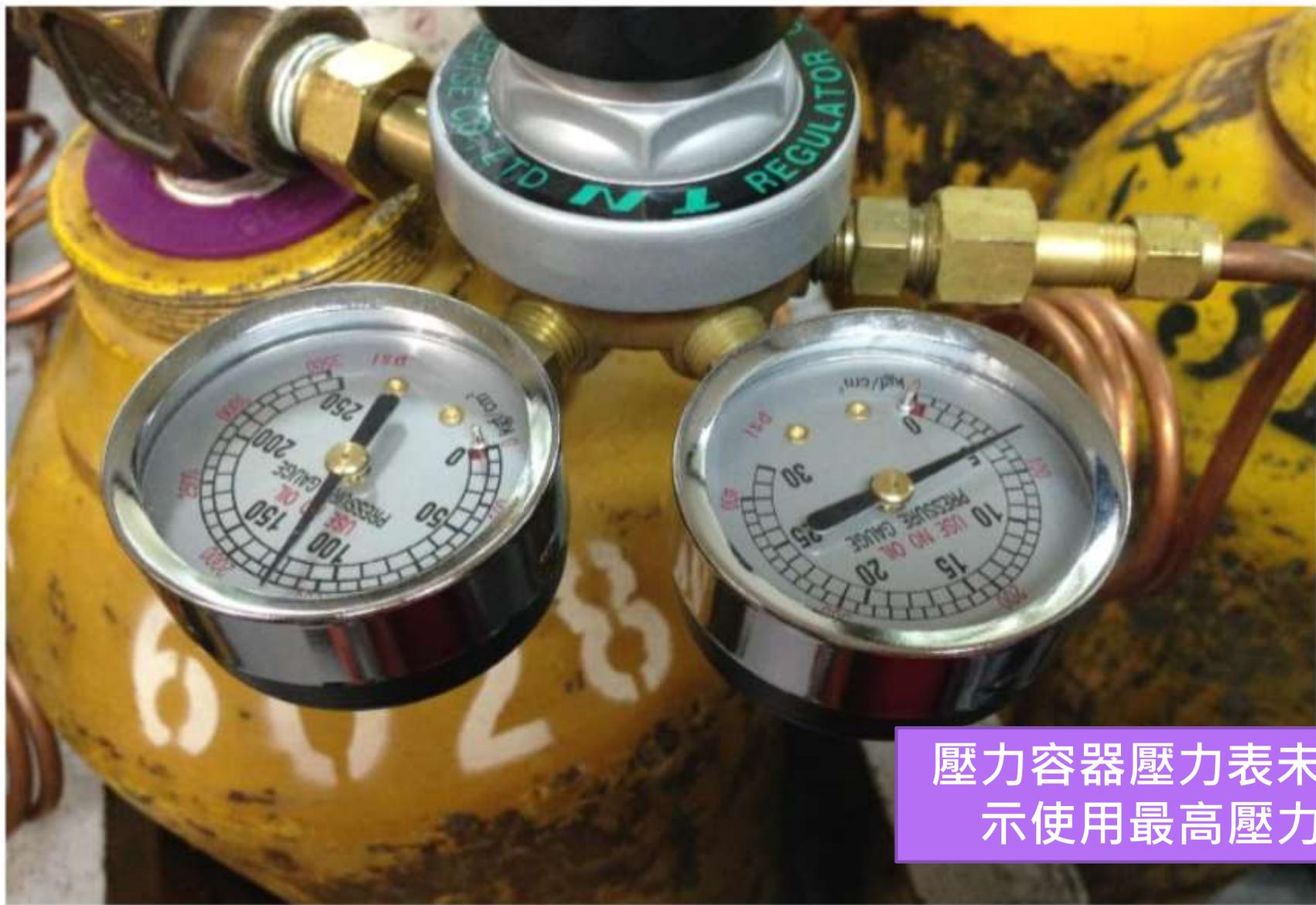
壓力容器壓力表未標示使用最高壓力
