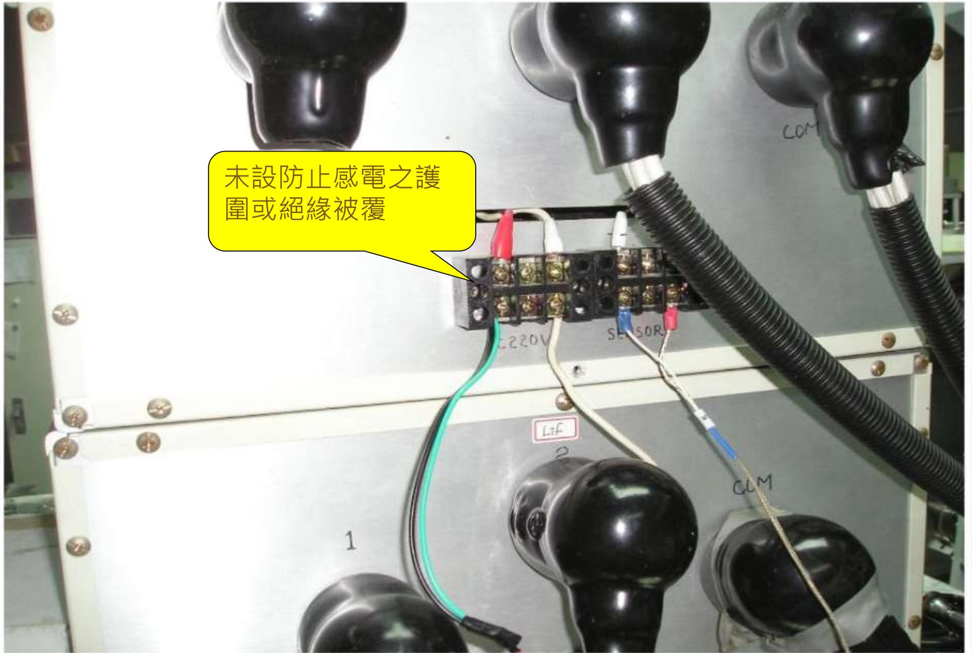
電機科配電檢定場部分閘刀開關護罩脫落
