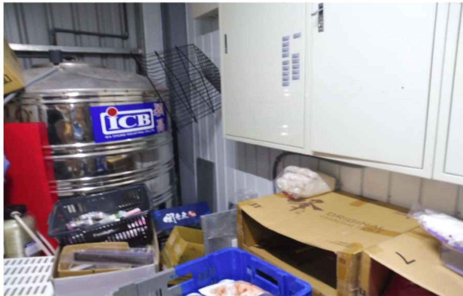
沖淋設備水加壓機設置位置不適當沖淋造成潮濕感電危害
