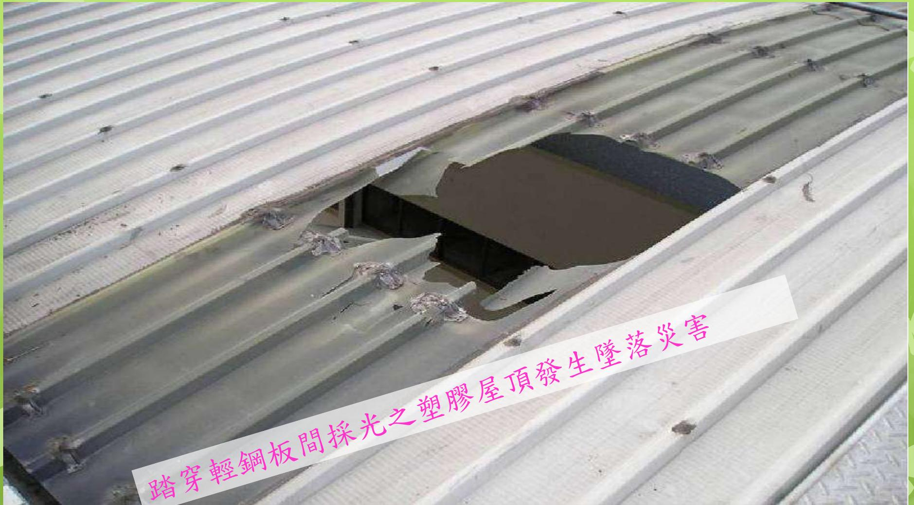
踏穿輕鋼板間採光之塑膠屋頂發生墜落災害
