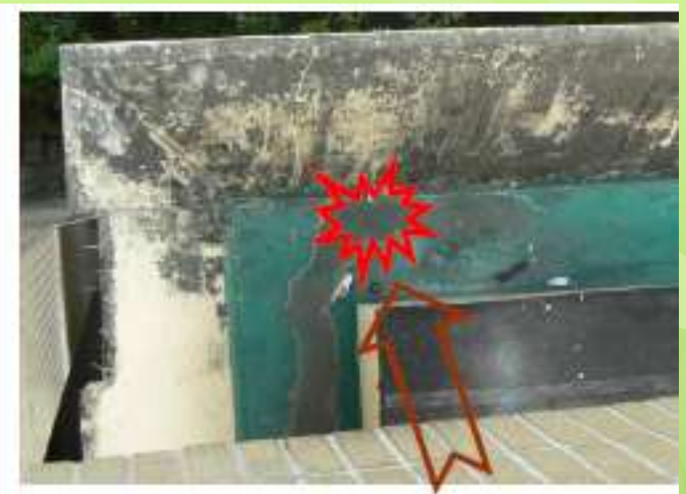
鄰棟體育館頂樓樓板 (約 13 公尺高)
