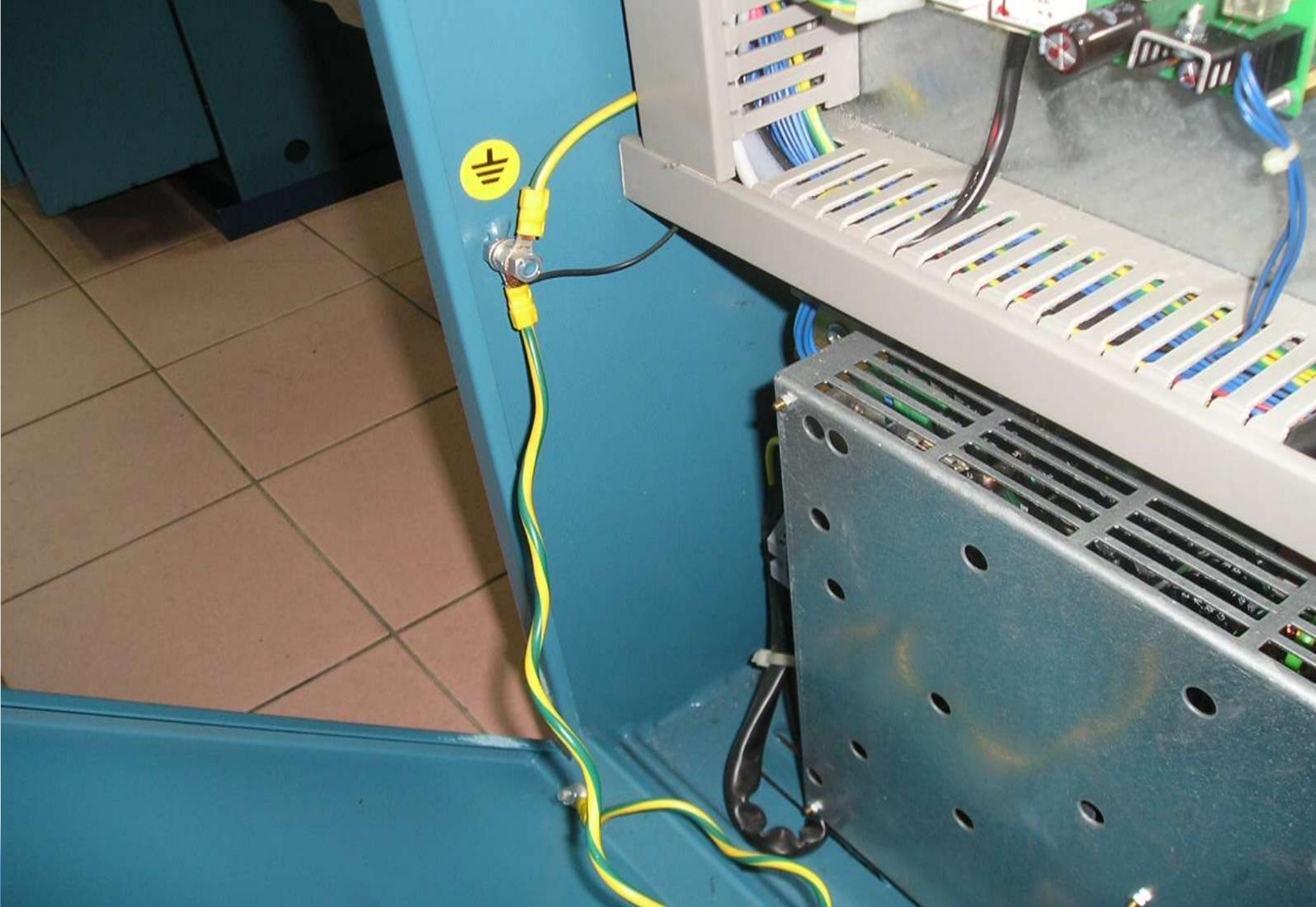
電氣設備外殼做好接地保護措施，可將漏電
