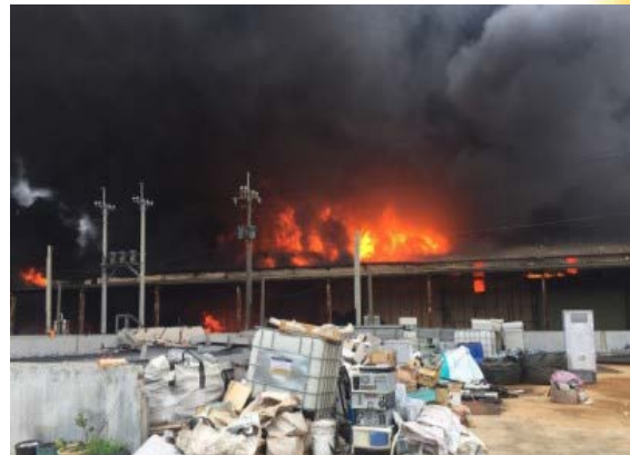
現場鐵皮工廠全面燃燒，火勢猛烈。
