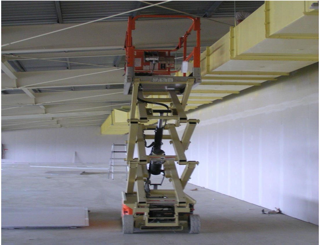
5、作業高度超過2公尺者，採用高空工作車之照片。
