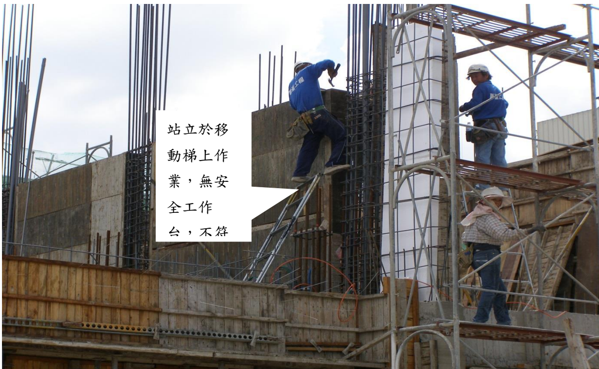
6、站立移動梯、合梯頂上作業無安全之工作平台，不符合規定之照片。
