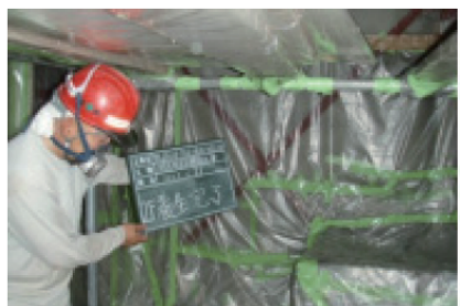
工作區域圍護、安全區設置
