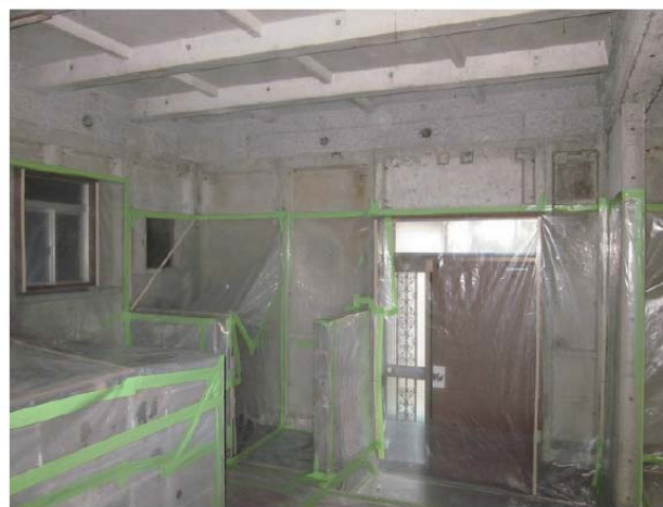
（圖片來源：建築物含石綿成分建材體檢手冊）
