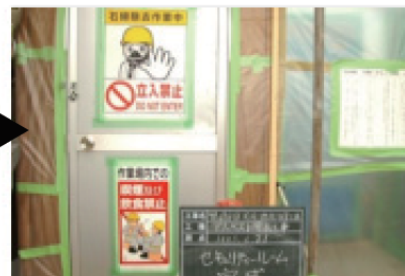
警告標誌設置
