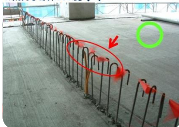
鋼筋尖端採180度彎勾
