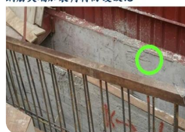
鋼筋尖端加裝角材防護設施
