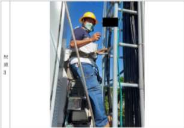
說明 腰掛式安全帶繞過固定梯示意圖
