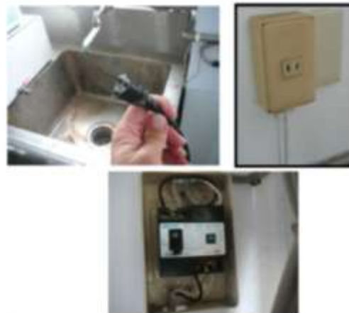
照片三 災害現場水浴槽連接之插頭及插座(未有接地孔)及電源所置設之漏電斷路器(災害發生後震毀)
