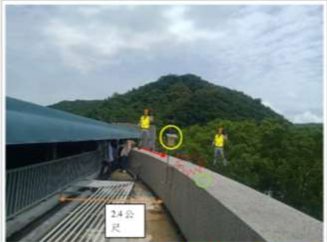
沿女兒牆行走欲拿取放在女兒牆上的電動起子，惟跨起而重觀測器時墜落。
