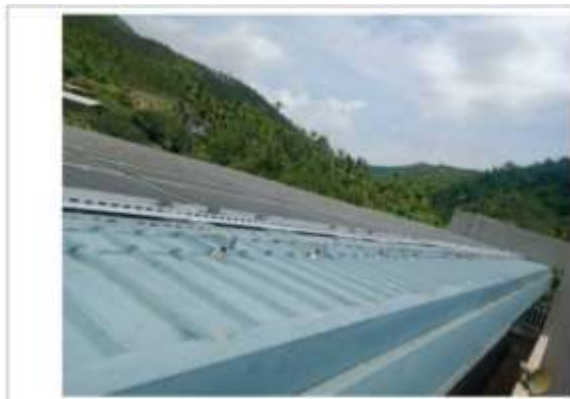
當時太陽能屋頂之安全通道角鋼已經固定好
