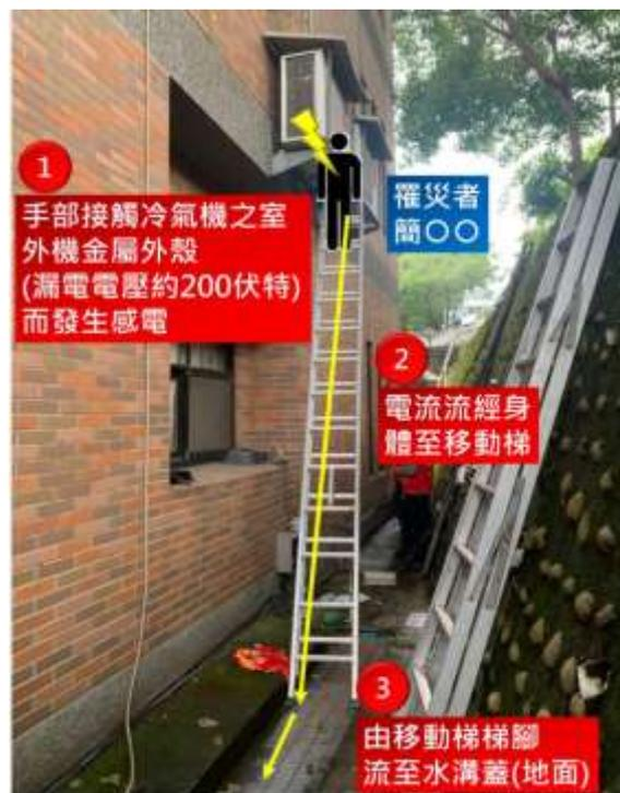
罹災者簡○○發生感電形成電流回路示意圖
